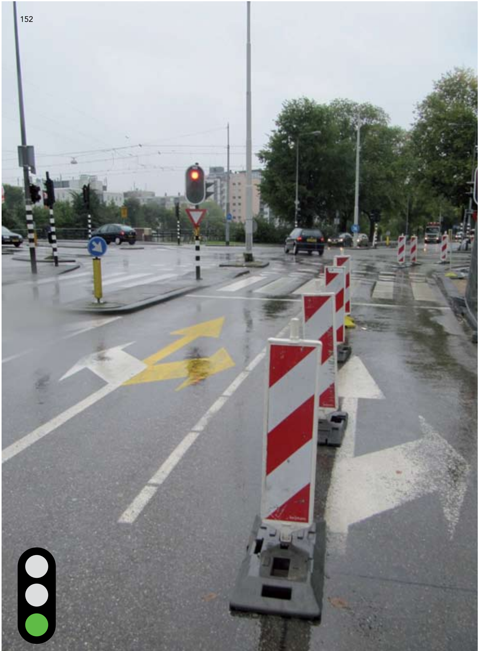
Goed aangebrachte tijdelijke belijning.
