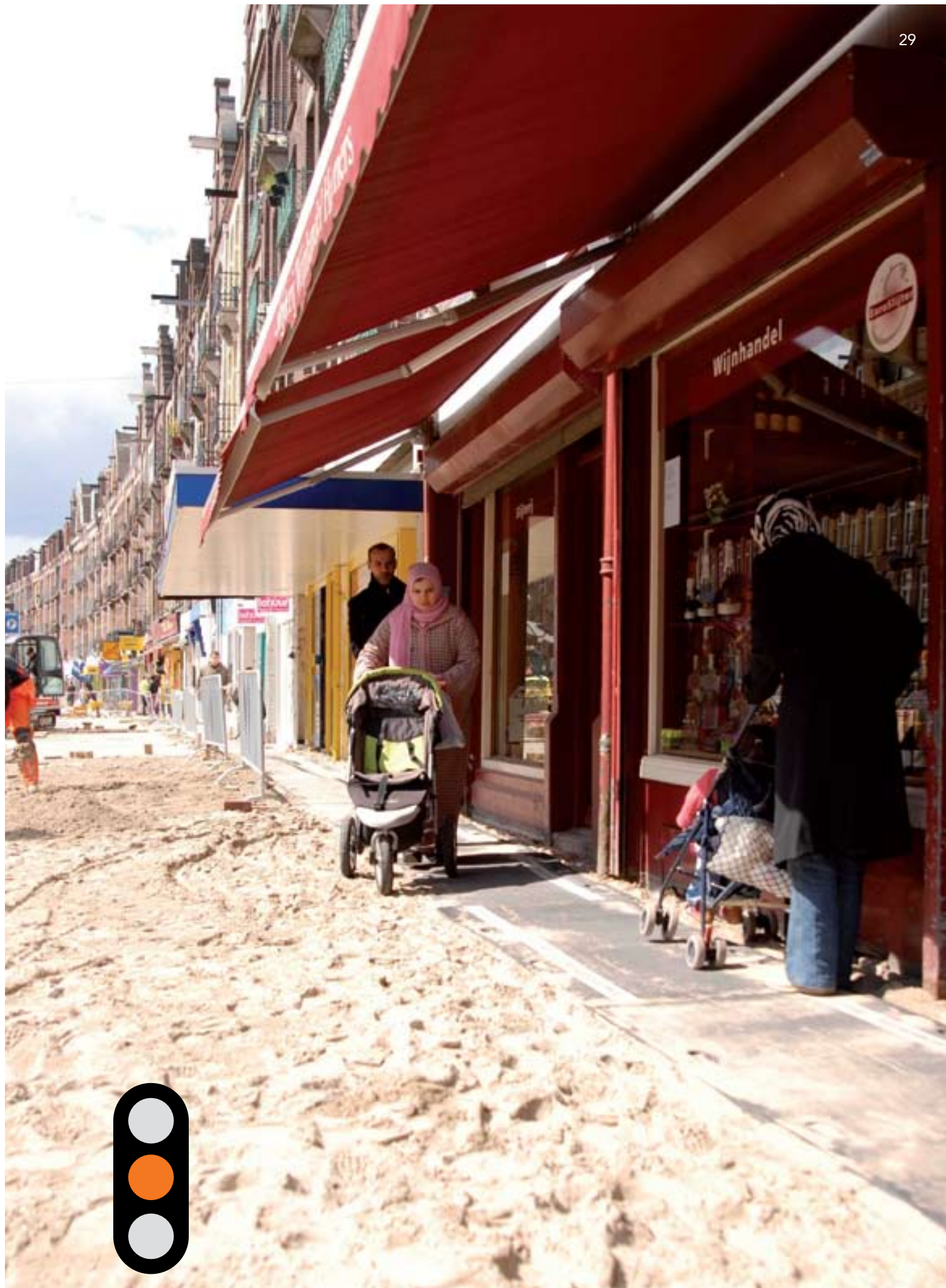
Te smalle loopschotten voor een winkelstraat.
