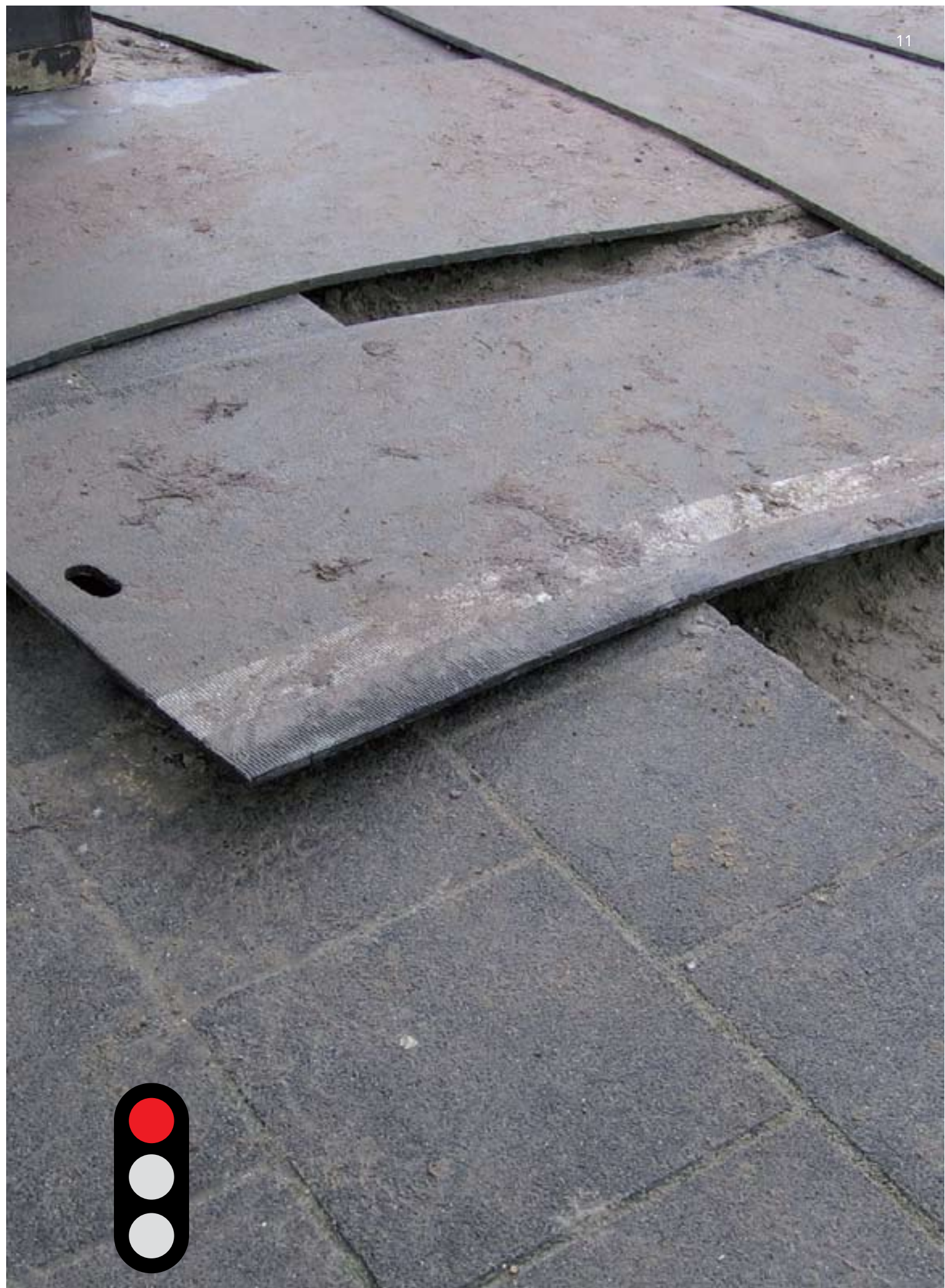
Voorkom valpartijen. Leg loopschotten recht en stabiel neer.
